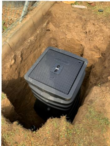
In der Ausstattungsvariante mit druckwasserdichtem Deckel ist darüber hinaus ausgeschlossen, dass Grundwasser in den Schacht eindringen und somit Armaturen langfristig schädigen kann.
