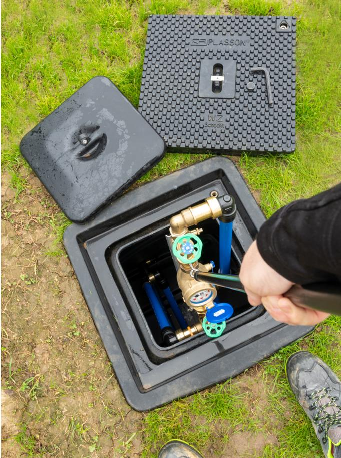
Durch das scherenförmig ausziehbare Leitungspaket aus PE 100 RC ist es nicht nötig beim Ablesen des Wasserzählers in den Schacht zu steigen. Der Zählertausch bzw. das Ablesen kann somit ganz einfach von einer Person erledigt werden.
